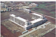
小平校舎竣工当時 (1964年頃)
