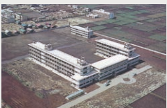
小平校舎竣工当時 (1964年頃)
